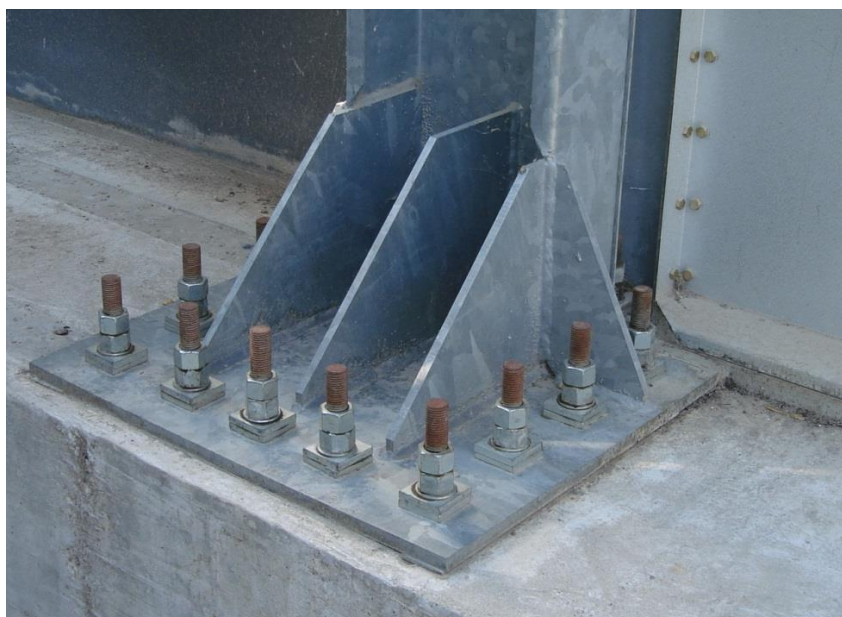
Схема 24 Основание сушилки, установленное прямо на поверхности фундамента
