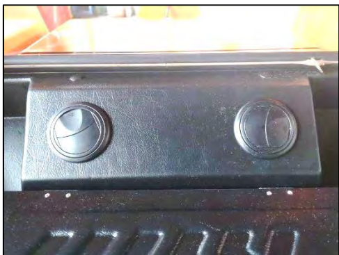
Рис. 27Е- Выходные заплюпочные клапана отопления - закрытые
