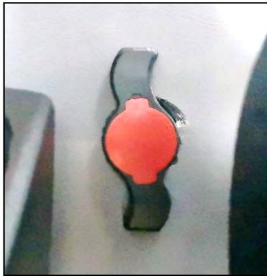
Рис. 27А- Клапан открыт - отопление
