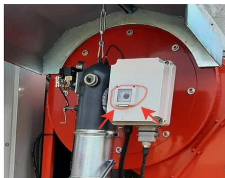
4) **Гаснет горелка, уходит в аварию** – для начала попробовать сбросить ошибку (написано выше, пункт 3), после чего почистить фотозлемент, следом идет проверка топливной системы. Для начала требуется проверить давление на горелке, значение должно быть показано около 15 Бар.
