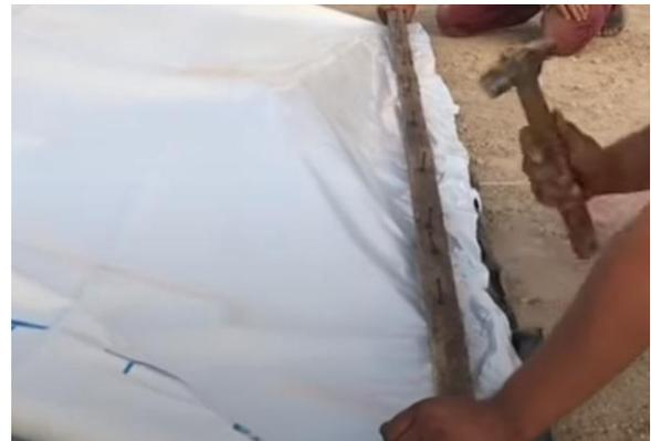
7. По периметру трамбовочного туннеля натяните резиновый прижимной шнур. Его функция – притормаживать рукав при его заполнении и предохранять его от преждевременного вытягивания.
